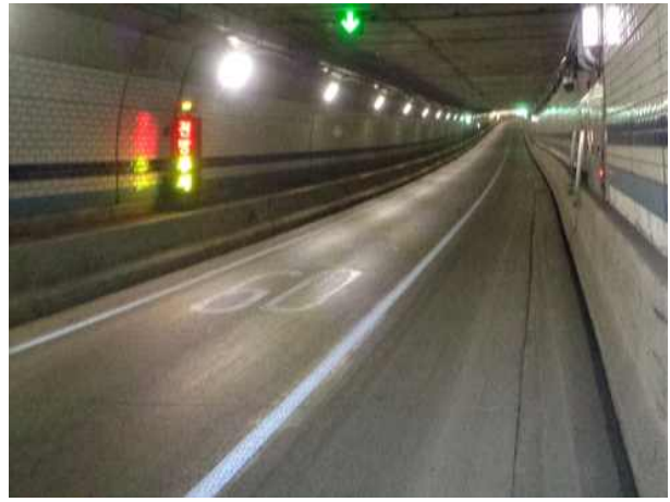
RAMP-C 포장부 전경
