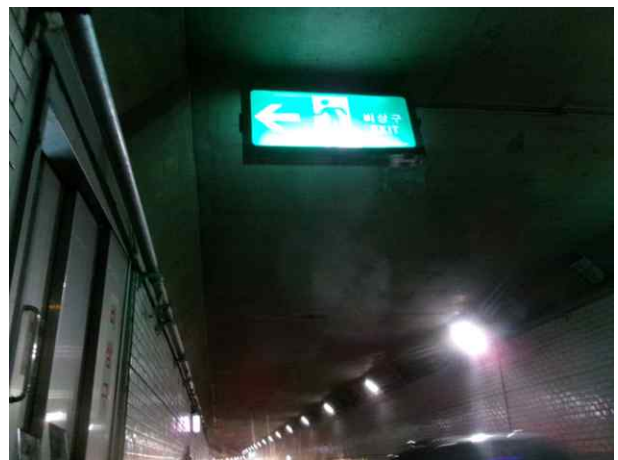
RAMP-C BOX구간 슬래브 전경
