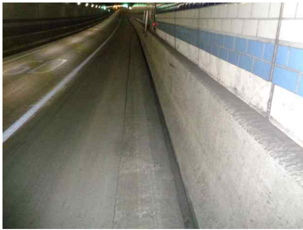
RAMP-C 배수시설 상태양호
