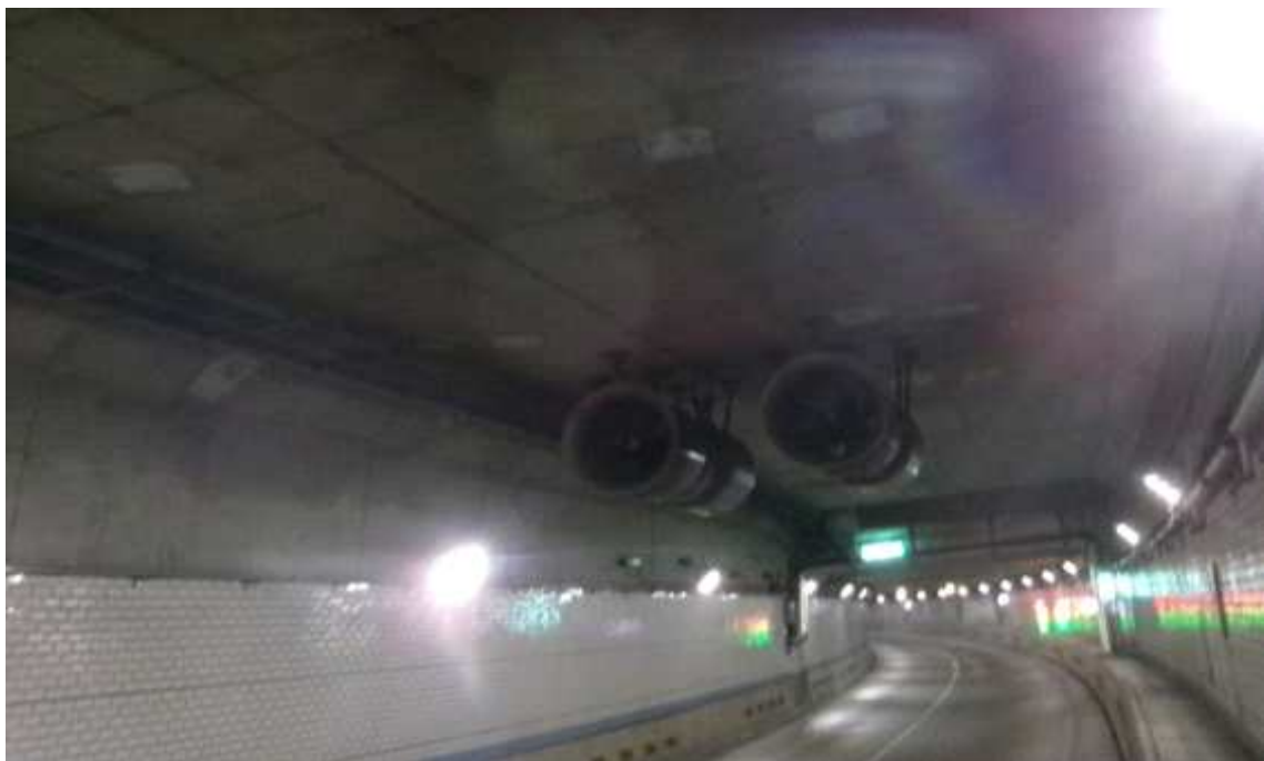
BOX구간 슬래브 전경
