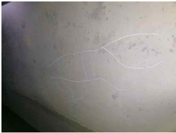
RAMP-C NATM구간 측벽부 S21 망상균열(Cw=0.1~0.2mm)
