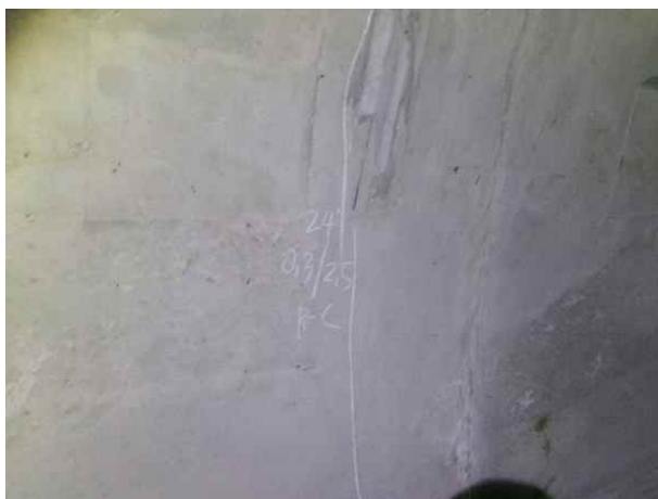
RAMP-C NATM구간 측벽부 S32 균열(Cw=0.3mm)
