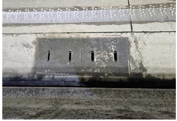
본선 배수시설 상태양호
