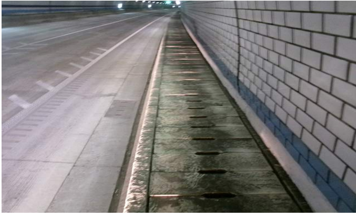
NATM구간 공동구 전경
