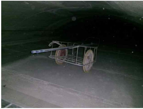
RAMP-C 풍도슬래브 S53 내부 자재적치
