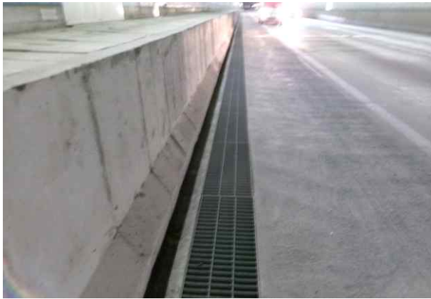
본선 배수시설 상태양호
