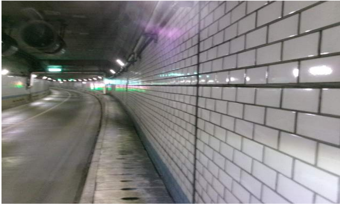
BOX구간 벽체 전경
