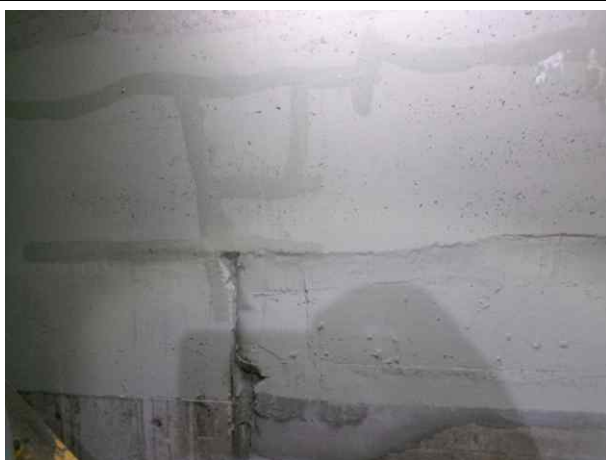
RAMP-C 전기실 백태보수 양호
