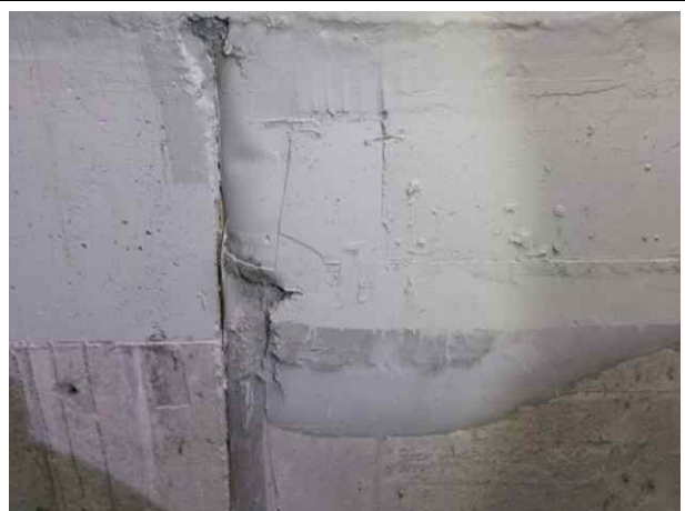
RAMP-C 전기실 누수보수 양호
