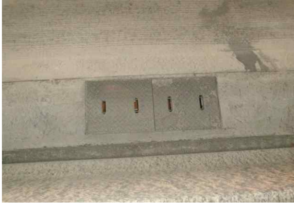
본선 배수시설 상태양호
