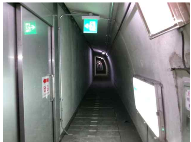
RAMP-C BOX구간 내부벽체 전경
