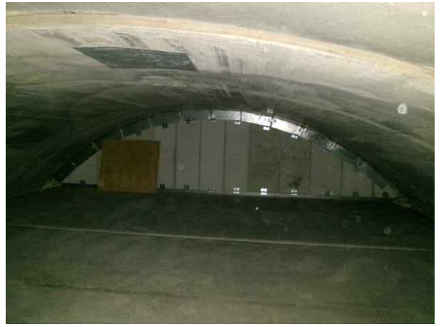
풍도슬래브 내부 전경(격벽)
