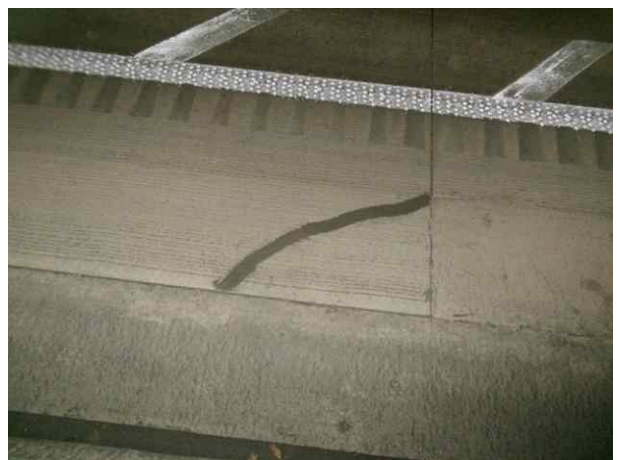
본선 포장부 균열보수 양호
