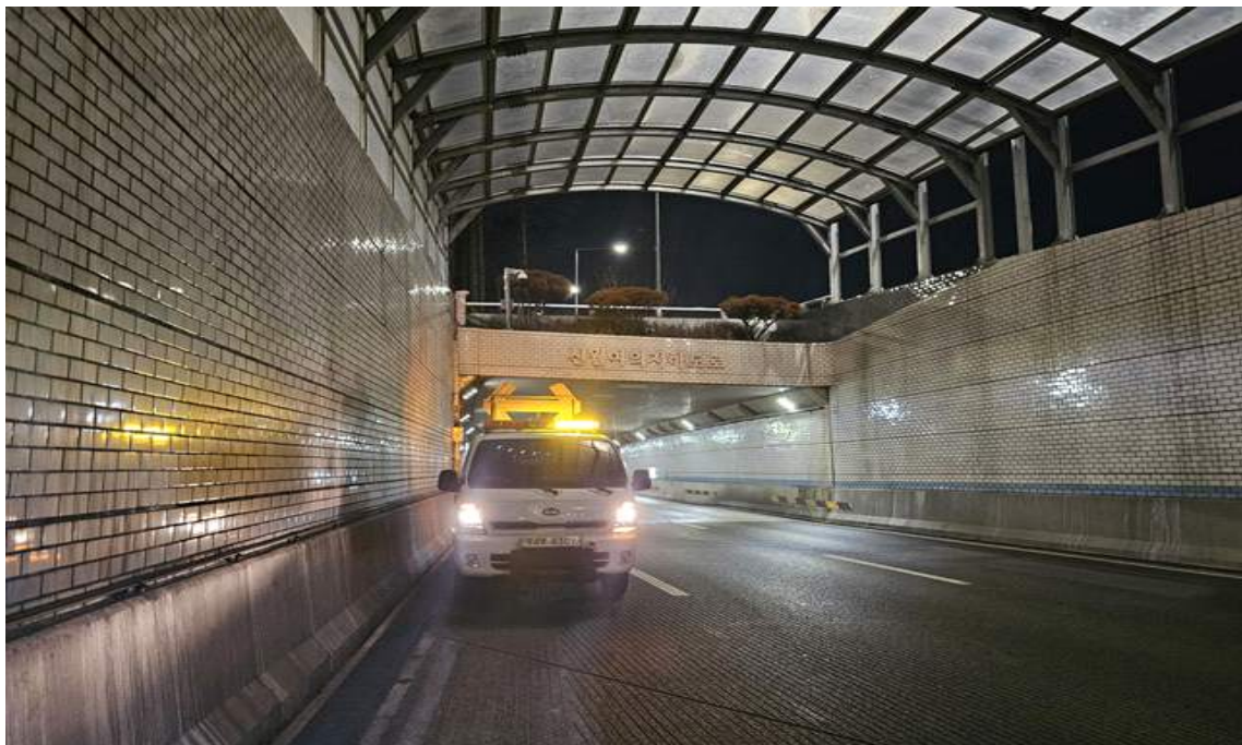
갱문 종점부 전경
