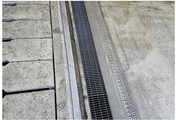
본선 배수시설 단면변화부 배수덮개 상태양호
