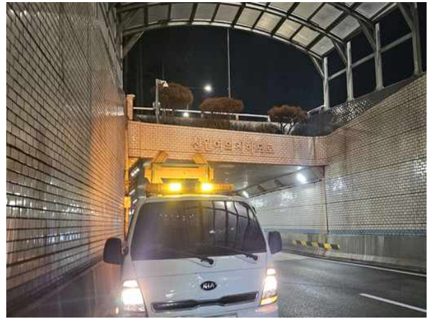
갯문 종점부 상태양호
