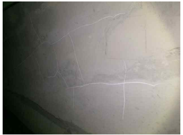
RAMP-C NATM구간 측벽부 S22 망상균열(Cw=0.1~0.2mm)
