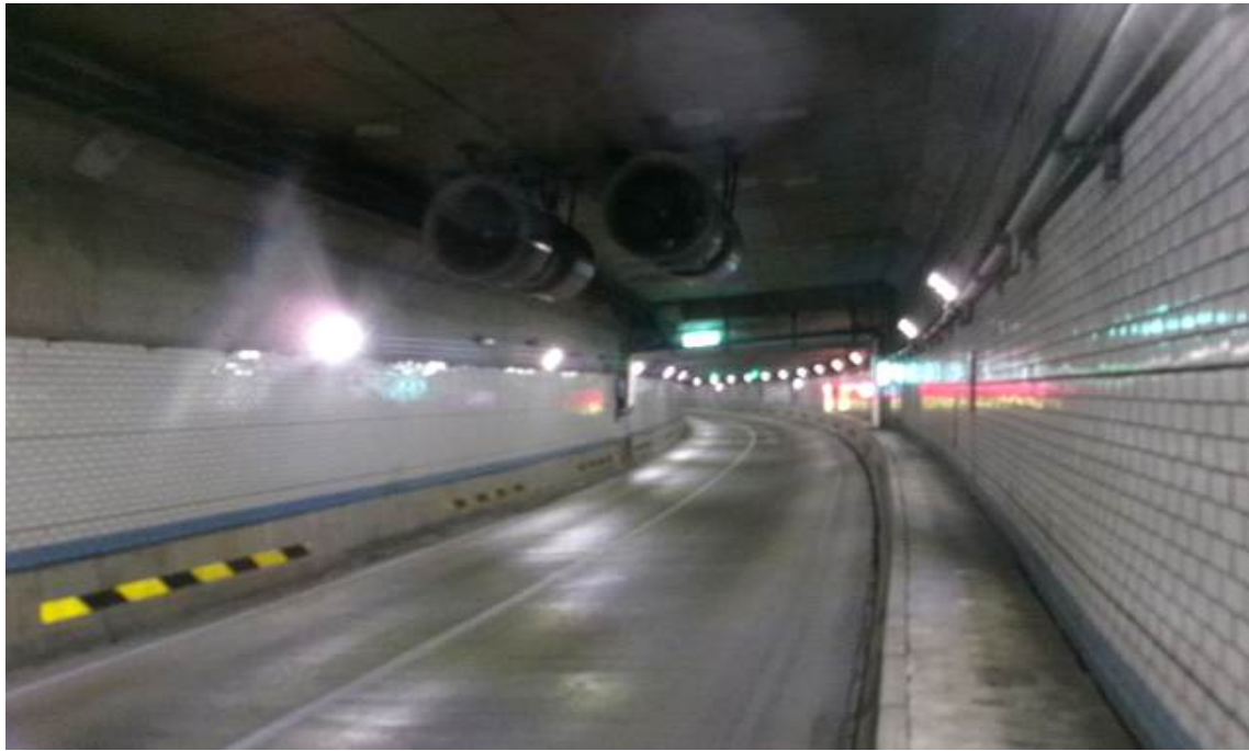
BOX구간 내부 전경
