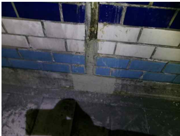
본선 NATM구간 측벽부 누수보수 양호
