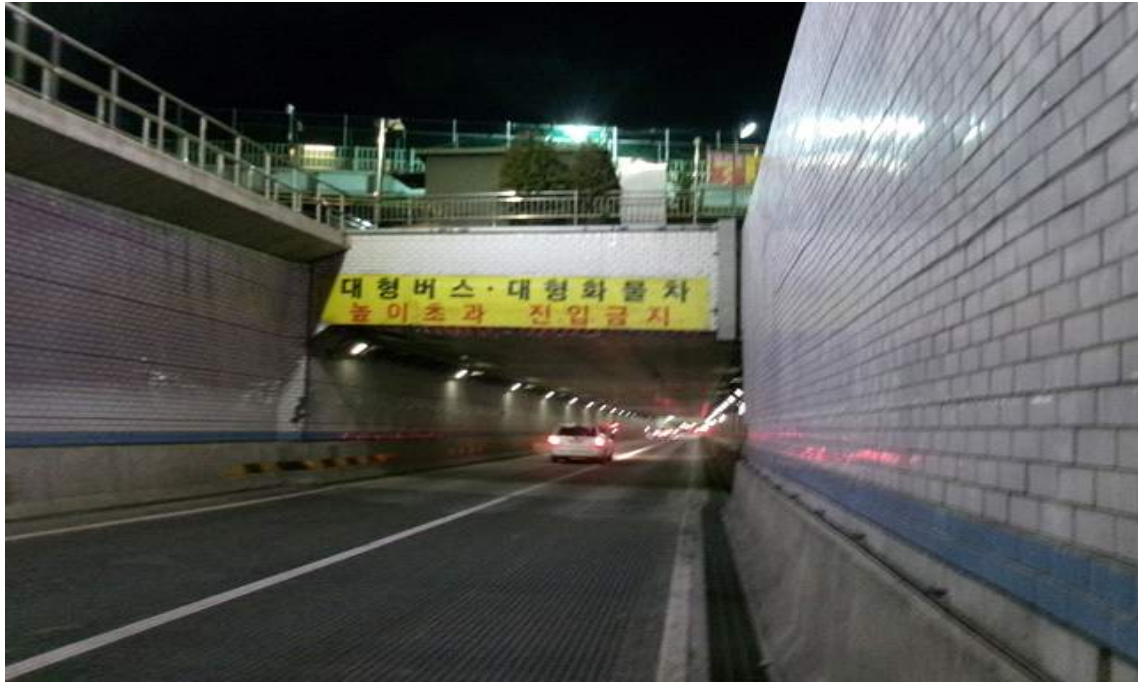
갱문 시점부 전경
