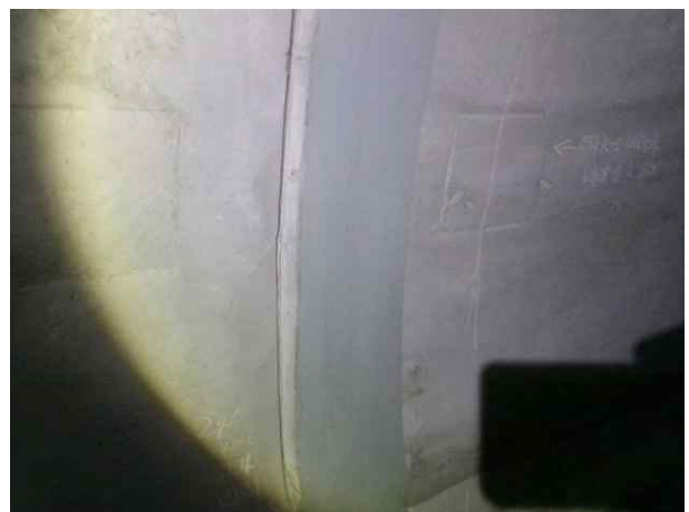
RAMP-C NATM구간 측벽부 백태보수 양호
